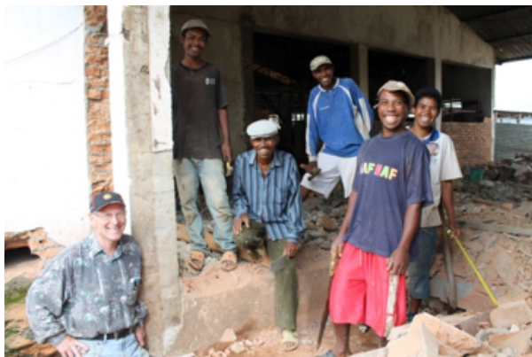
Dugnad februar-14. Rolf Moi og glade medarbeidere. Utgraving til ny melkestall
