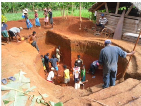
Utgraving til en biogasstank
