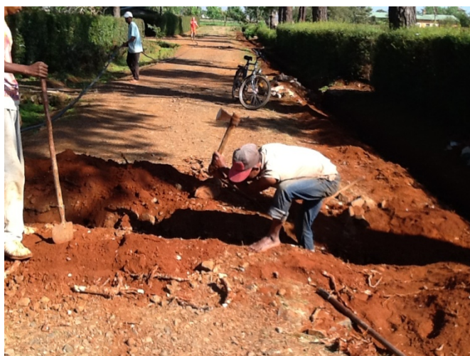
Graving av grøfter på hele skoleområdet
