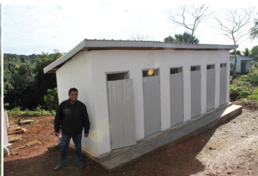
Det nye toalettanlegget fungerer godt
