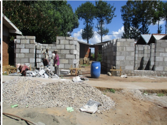
Bygging av toalettanlegget er i gong
