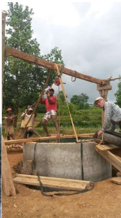
Rolf Moi og medarbeidarar ved den nye brønnen
