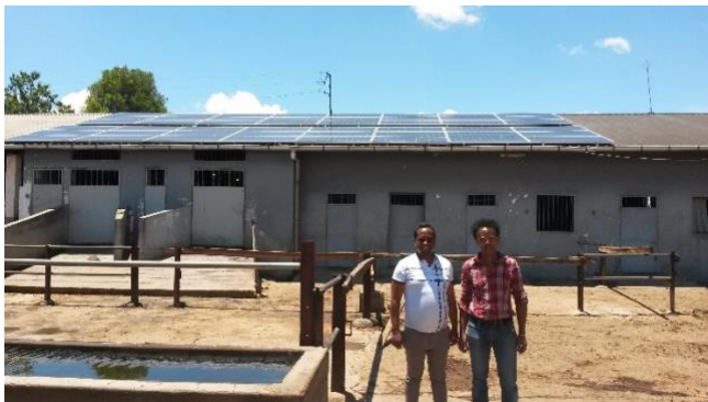
Rektor Rasoloson Lala og fjøsmeisteren framfor solcelleanlegget Foto: Arne Dragsund
