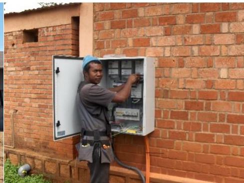
Mekanikar Lalaina i gong med montering i skapet Foto: Kolbjørn Lerstøl
