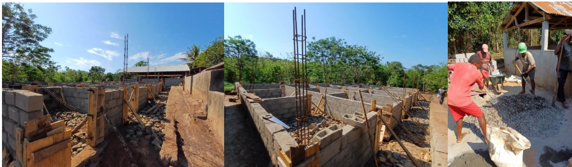
Bygginga av det nye grisehuset i gang i november 2024. Foto: Arne Dragsund
